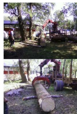
Dépôt des bois sur l'emplacement du chantier prévu
